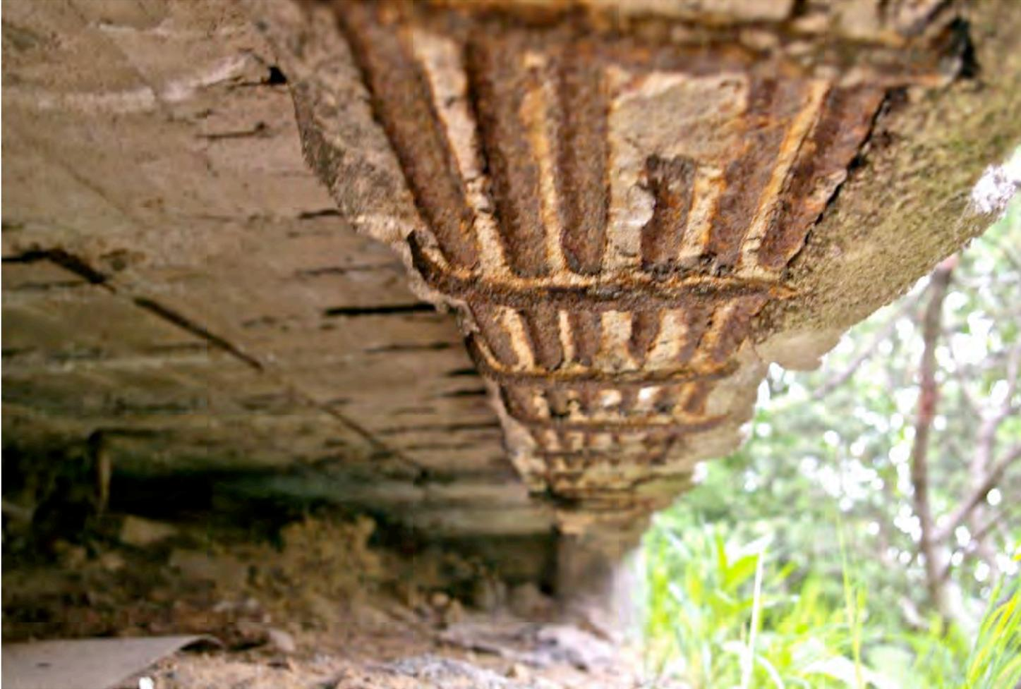
La cabeza de compresión de hormigón estaba bien, lo rescatamos pegando la armadura necesaria (Spritzbeton)
